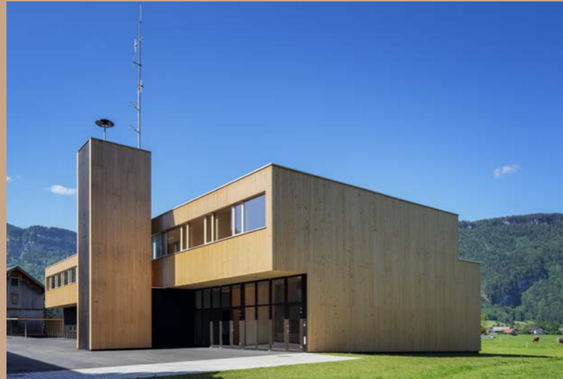
Sicherheitszentrum Bezau // Ein Solitär in der Landschaft: Das neue Zuhause der Feuerwehr ist bis auf wenige Details eine reine Holzkonstruktion und trägt ein Fassadenkleid aus Fichte.
