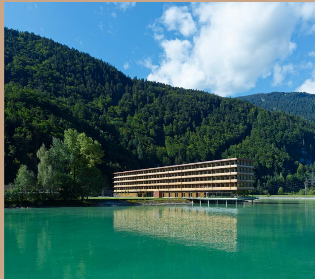
Illwerke Zentrum Montafon, Velden // Superlativ im Supertempo: Zum Zeitpunkt der Fertigstellung 2013 war das 120 Meter lange Zentrum das größte Bürogebäude aus Holz in Mitteleuropa, das Fügen der Holzkonstruktion brauchte gerade einmal sechs Wochen. Um es auf der Baufäche unterzubringen, ließen die Architekten den Riegel über den See kragen. Mittlerweile wurden auch andere Holzgebäude in ähnlichen Dimensionen realisiert.
