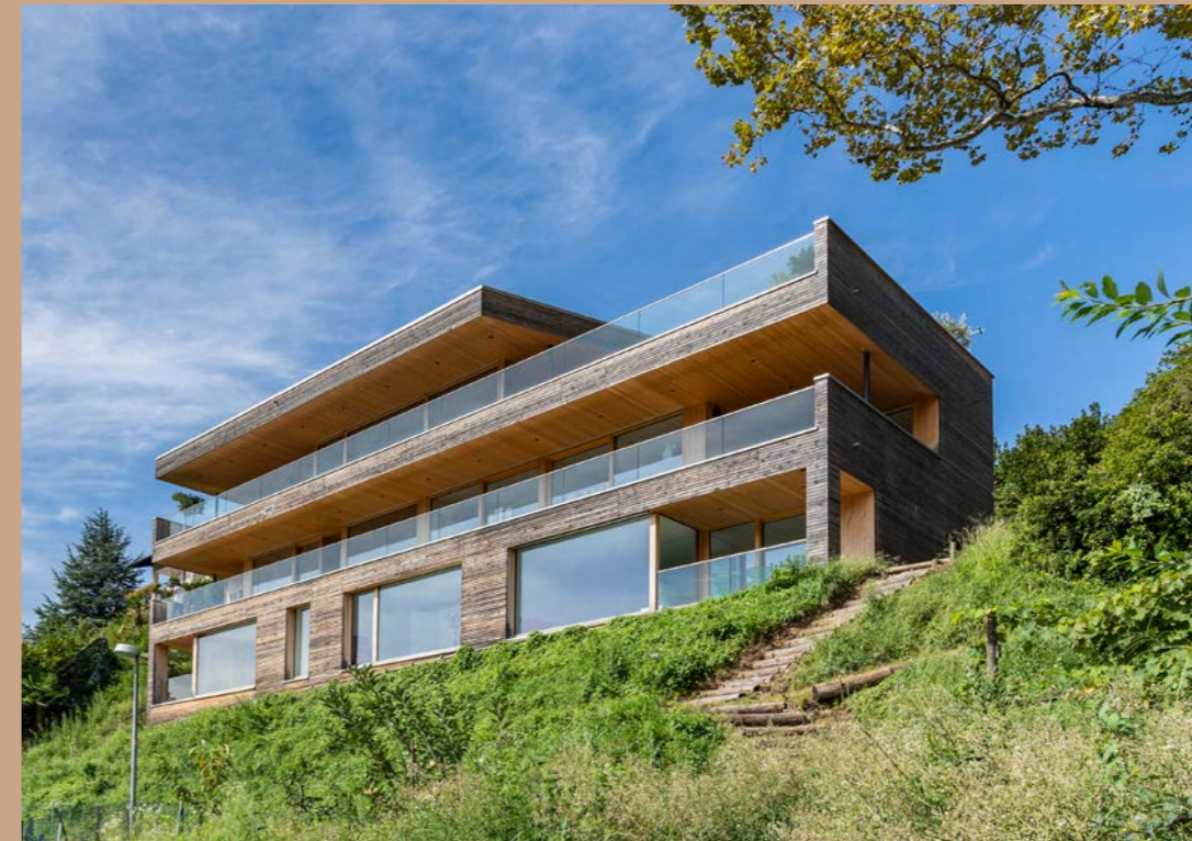
Lino, Montagnola // Die Lage als Entwurfsparameter: Der fast schwebend wirkende Baukörper sitzt an einem steilen Hang mit Panoramablick über den Lago Lugano. Holzelementwände, Brettschichtdecken und eine Innenwandverkleidung aus Tanne kommunizieren Haptik und Wärme.
