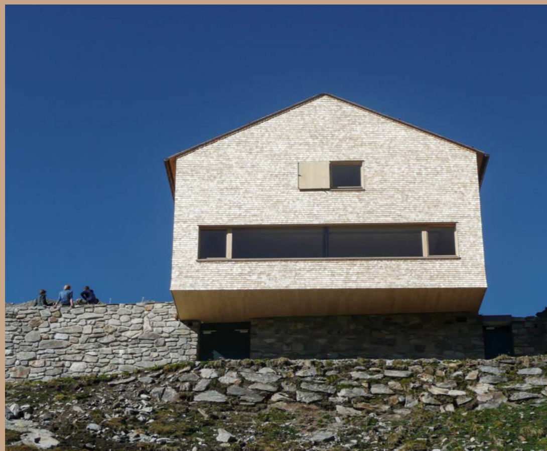
Olpererhütte // Auf 2400 Metern wurden die in der Zimmerei vorgefertigten Elemente mit dem Helikopter angeliefert. Hermann Kaufmann: „Einzigiger Luxus ist das riesige Panoramafenster ins Tal. Doch dafür kommt man ja rauf.“
